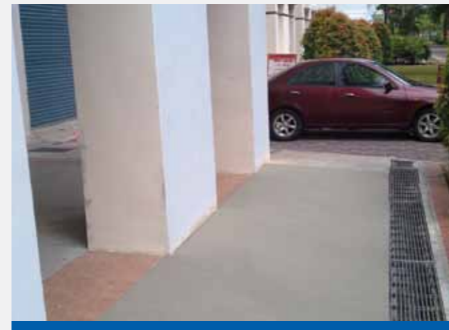
HDB APRONS & WALKWAYS
